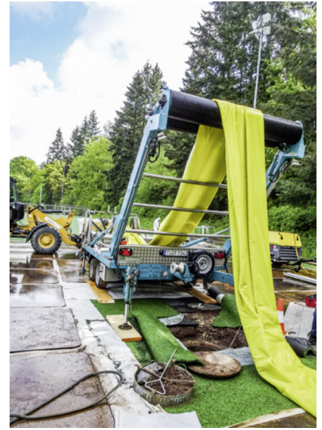
Schlauchlinereinbau | Fotos: Werner Bezela
