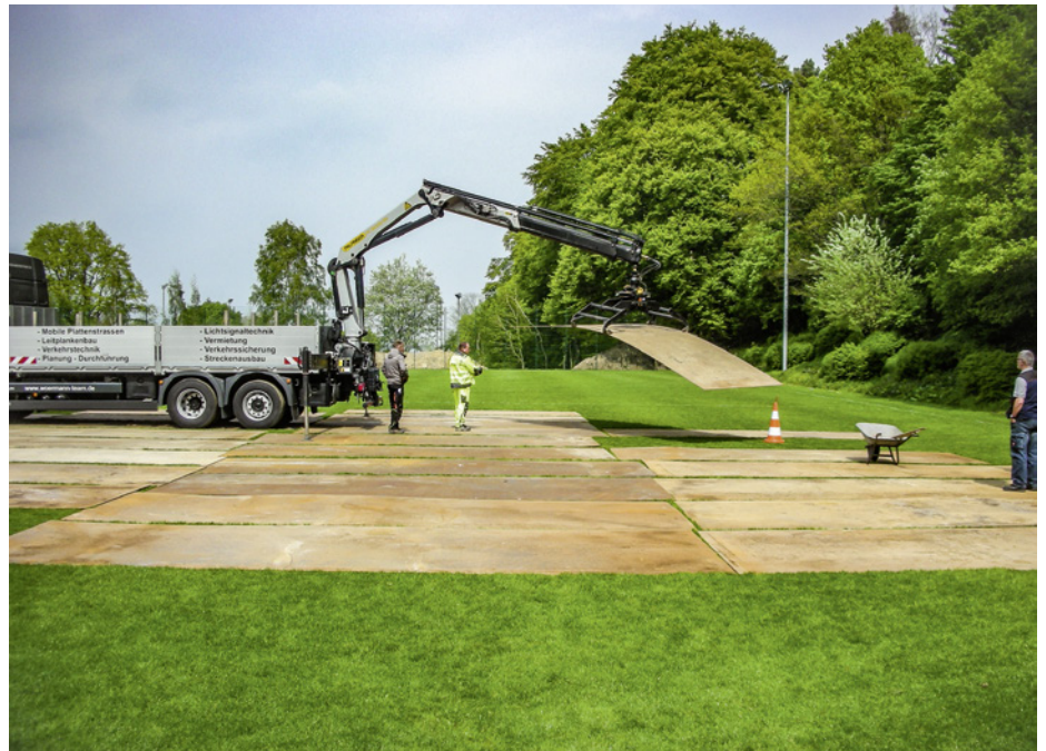
Auslegen der Stahlplatten
