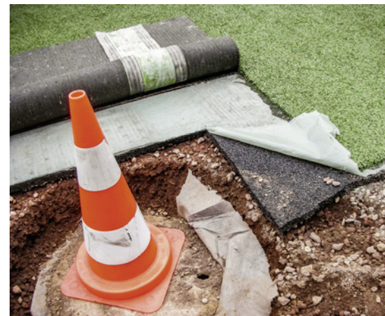
Öffnen der Kunstrasenbahn im Schachtbereich
