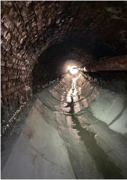
Teilfertige Sohlsole nach Ausbau der Schalkkörper. Das Licht im hinteren Bereich des Kanals lässt bereits deutlich die gewünschte Kreisform erkennen. | Foto: SMG
