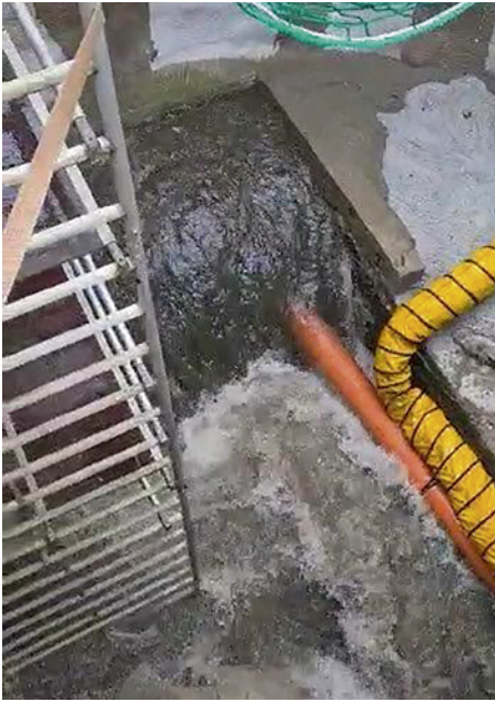
Das Profil: Rechteck mit aufgesetztem Halbkreis | Foto: Stadtbetriebe Unna
