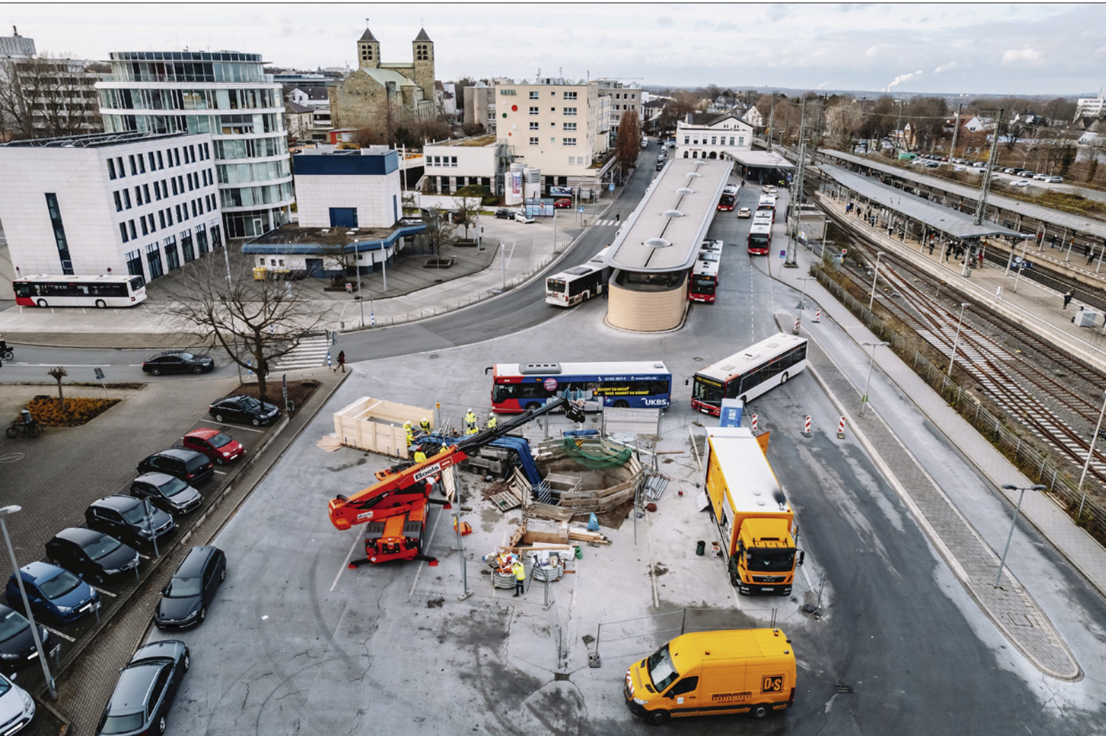
Sanierungsprojekt Kortelbach an exponierter Stelle: Bahnhof Unna | Foto: D&S
