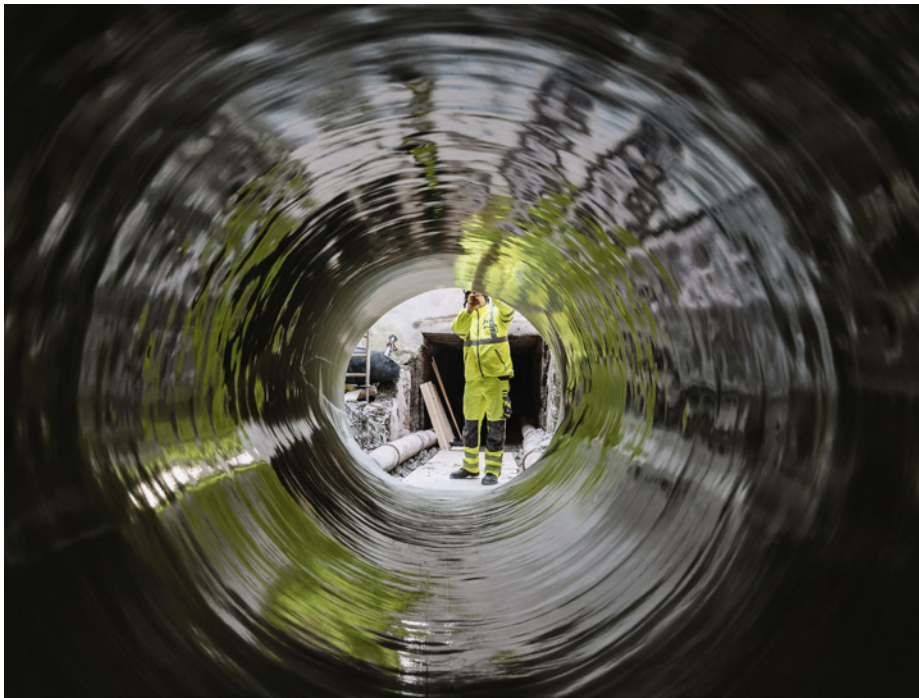
Erfolgreicher Abschluss des Sanierungsprojekts Kortelbach | Foto: D&amp;S
