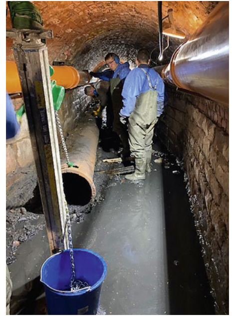
Durch Hebelzüge mit einer Zugkraft von über 1,5 Tonnen, an verspreizten Schwerlaststützen befestigt, konnte der gesamte Rohrstrang Rohr für Rohr zerlegt werden. | Foto: SMG
