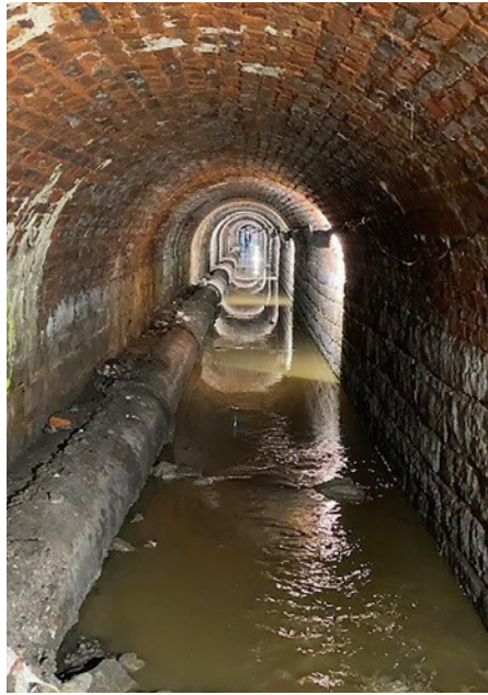
Überströmte Abwasserhaltung | Foto: SMG
